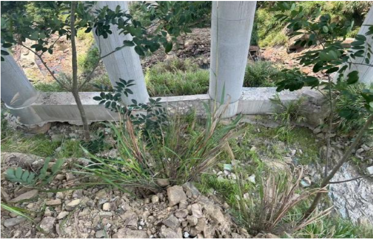
蔡江二号桥 15 号墩桩基现状
